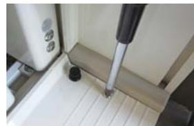
③下枠、両側のネジをプラスドライバーで外し、黒色のボタンを上へ引っ張って下さい。
