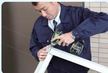
5 上枠と縦枠を垂直に組み合わせ
