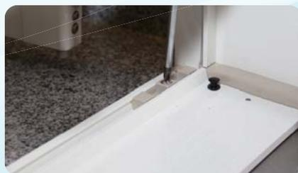
20 下部ガイドを設置したい方の吊元にネジ止めをし固定します
