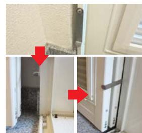
②室内吊元側下にあるL型ステーを起こし(90度回転)本体障子を固定して下さい。
