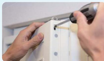
24 開閉調節でドアの硬さを調整します
