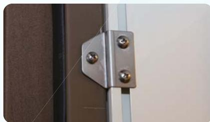
11 6か所ネジ止めをして、枠を固定します
