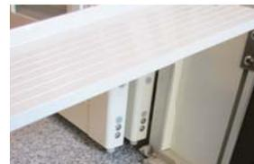
④下枠を持ち上げて取り外して下さい。下枠取付時は指詰めにご注意下さい。
