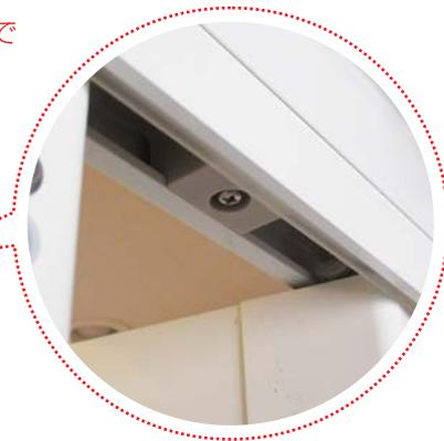
**手順 3** ①～④の手順にて吊り車を90度回転させ上枠レールより外して下さい。
