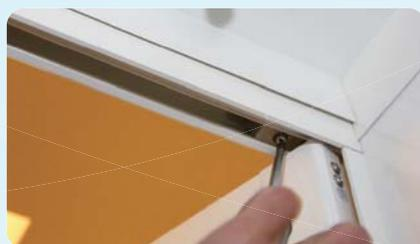
23 ストッパーをネジ止めし、ドアを固定します
